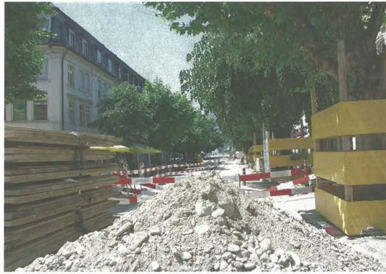
Noch ist die geplante Begegnungszone in der Hauptbahnhofstrasse eine einzige Baustelle.
