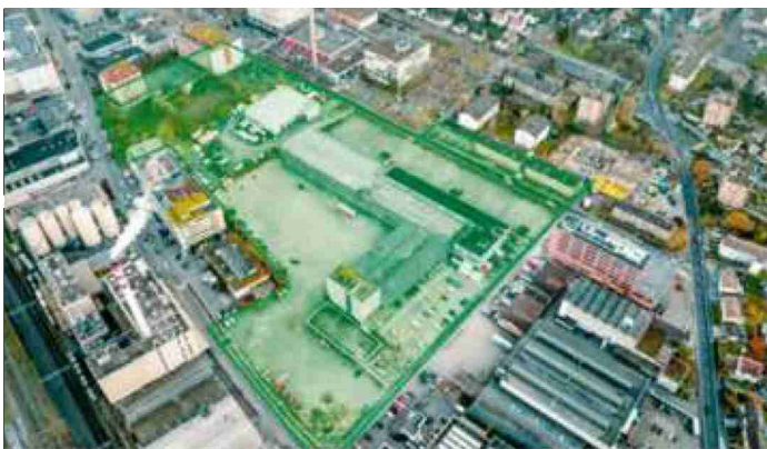
Luftaufnahme der Deponie Feldreben in Muttenz (BL). Der Standort ist teilweise überbaut.
